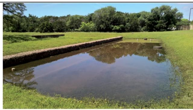
Fig. 5.5.2 esempio di un piccolo bacino di detenzione a tirante variabile
